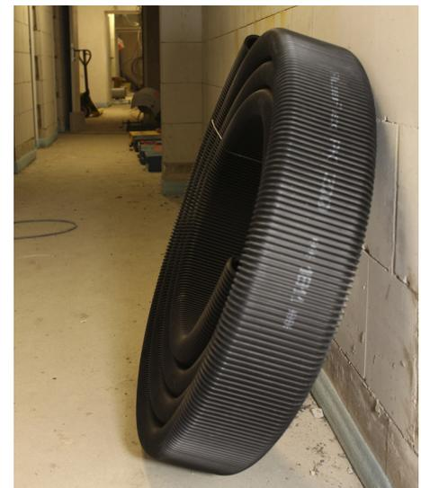
Was aussieht wie ein großer LKW-Reifen, ist der hochflexible Flex-Kanal, der die einzelnen Räumen mit Frischluft versorgt und die verbrauchte Abluft abtransportiert.
