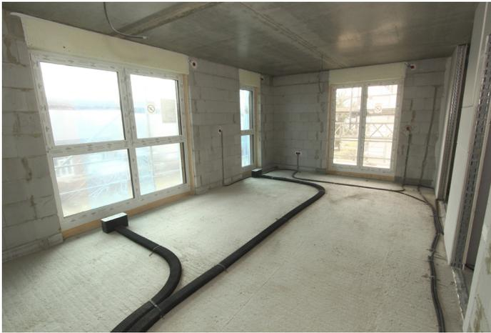
Die Flex-Kanäle für die Wohnraumlüftung werden direkt auf dem Rohfußboden verlegt, die Frischluftauslässe befinden sich im Bodenaufbau.
