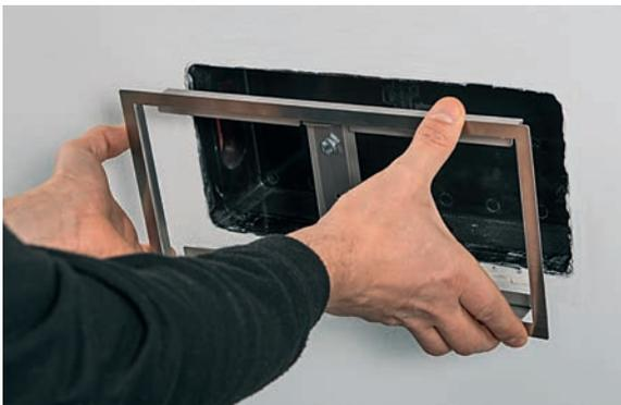
Der Einbaurahmen wird in den Luftauslass eingesteckt und mit dem entsprechenden Befestigungsmaterial auf die Auslassöffnung geschraubt. Bohrungen sind dafür nicht notwendig.
