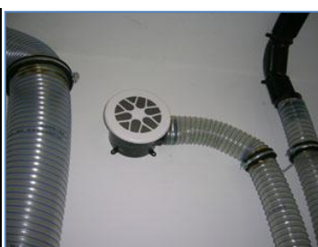
Bocchetta di estrazione dell'aria viziata
