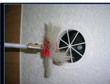
Bocchetta di estrazione dell'aria viziata
