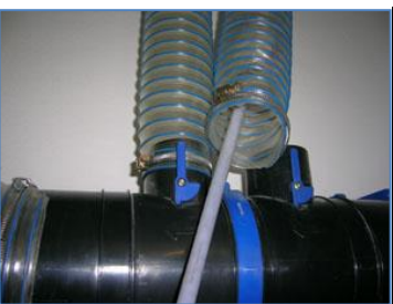
Pulizia in direzione della bocchetta
