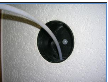
Reinigung Richtung Verteiler
